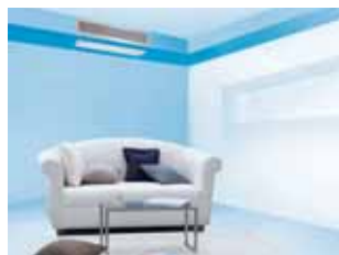
Teilweise abgehängte Decke
