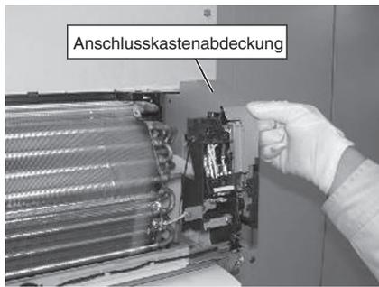
1. Abdeckung des Anschlusskastens abnehmen (Blechplatte).
