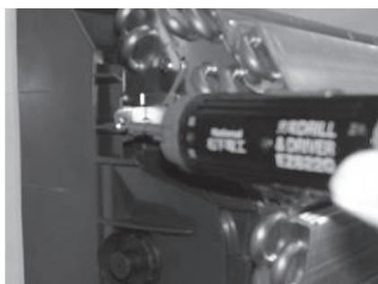
8. Schraube, mit der der Wärmetauscher an der Grundplatte befestigt ist, herausdrehen.
