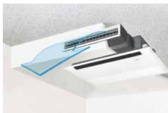
(3) Un système monté au plafond à une direction
