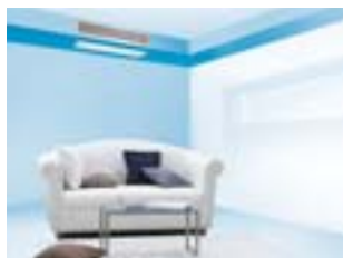
Teilweise abgehängte Decke
