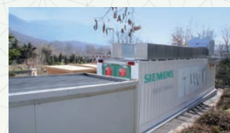
Siestorage Modulares Energiespeichersystem mit Lithium-Ionen-Akkumulatoren von Panasonic
