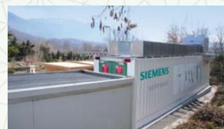
Siestorage Modulares Energiespeichersystem mit Lithium-Ionen-Akkumulatoren von Panasonic
