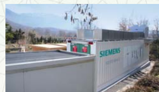
Siestorage Modulares Energiespeichersystem mit Lithium-Ionen-Akkumulatoren von Panasonic
