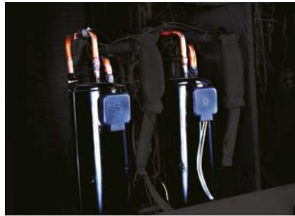
Ausschließlicher Einsatz von invertergesteuerten Hochleistungsverdichtern.
